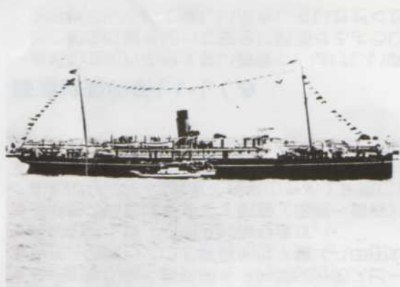
▼連絡船貨車航送 荷物を積んだ貨車をそのまま運びます。
