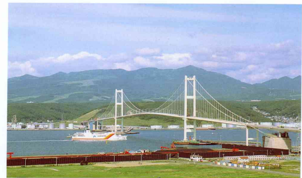
室蘭白鳥大橋 (平成10年6月開通) をくぐる「びるたす」
